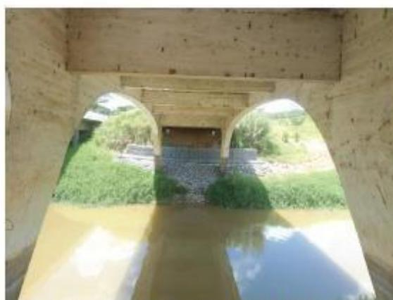
GABIÃO PARA PROTEÇÃO DE FUNDAÇÃO DE PONTE
