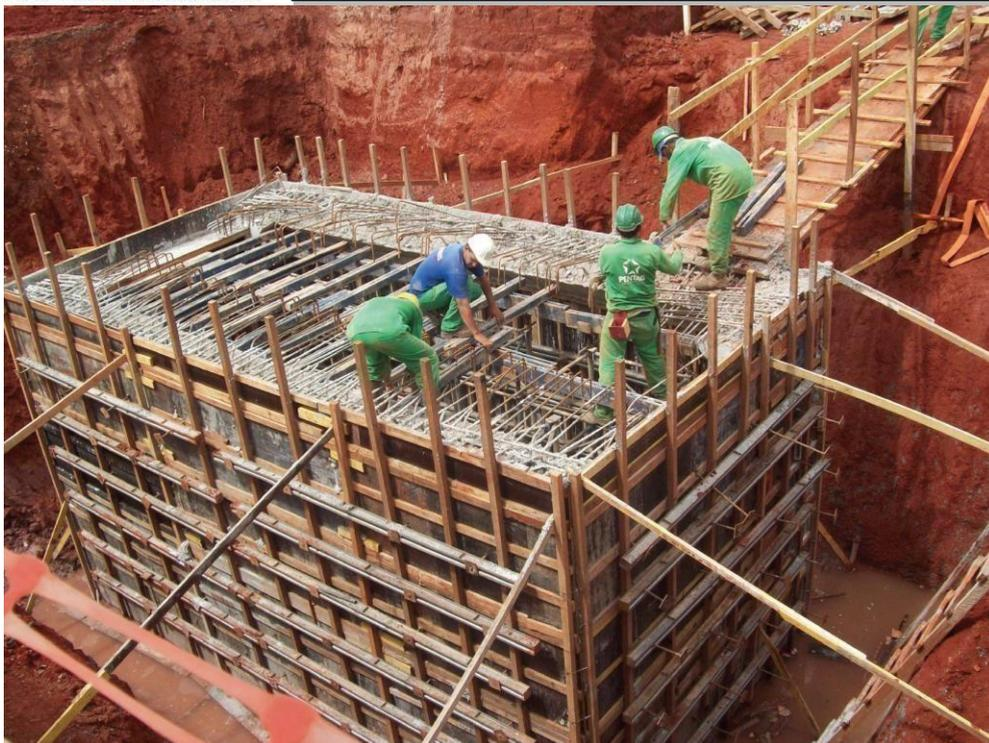
CAIXA DE CONCRETO ARMADO – RETENÇÃO PARA AGUA PLUVIAL – SHOPPING CENTER IGUATEMI, BRASILIA/DF
