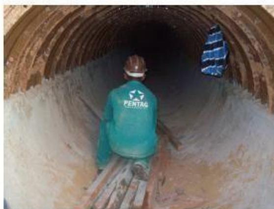
EXECUÇÃO DE TUNNEL LINER – PROCESSO NÃO DESTRUTIVO
