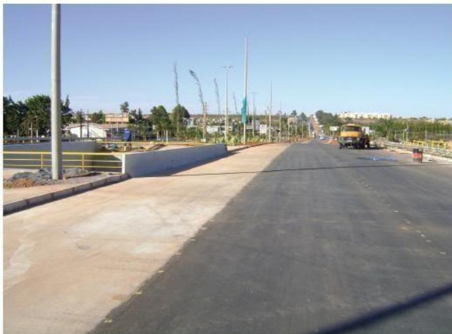
PAVIMENTO MISTO – CONCRETO RÍGIDO E ASFALTO
